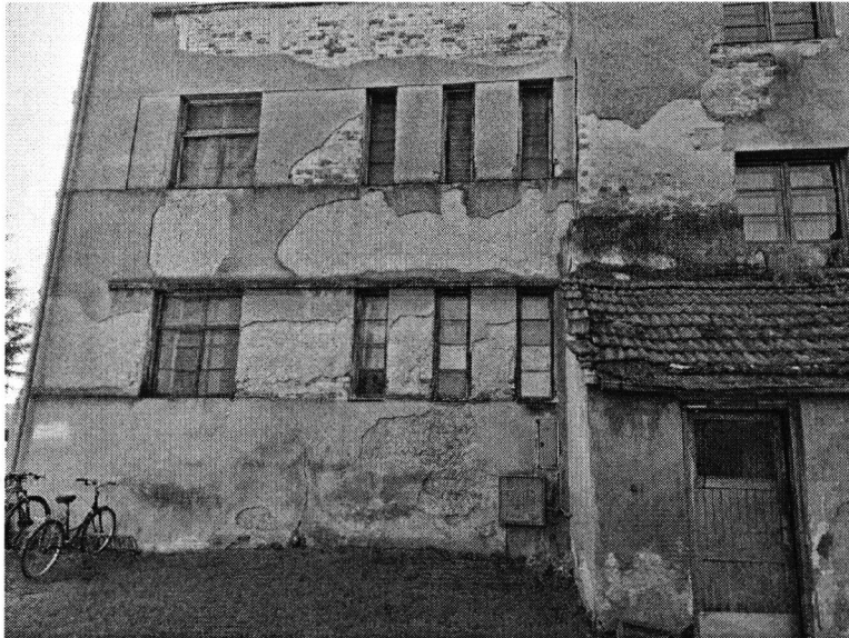
Dvorišni pogled –stan lijevo u zgradu
